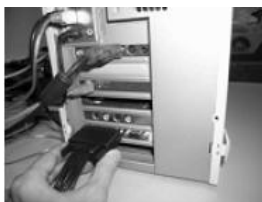
Рис. 2-2. Монтаж интерфейсного кабеля
